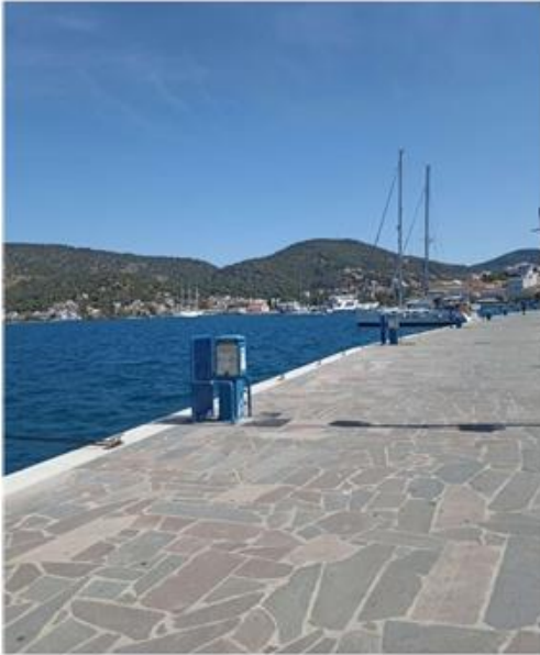
Φωτογραφία Υφιστάμενης κατάστασης που βρίσκεται πριν την περιοχή επέμβασης
