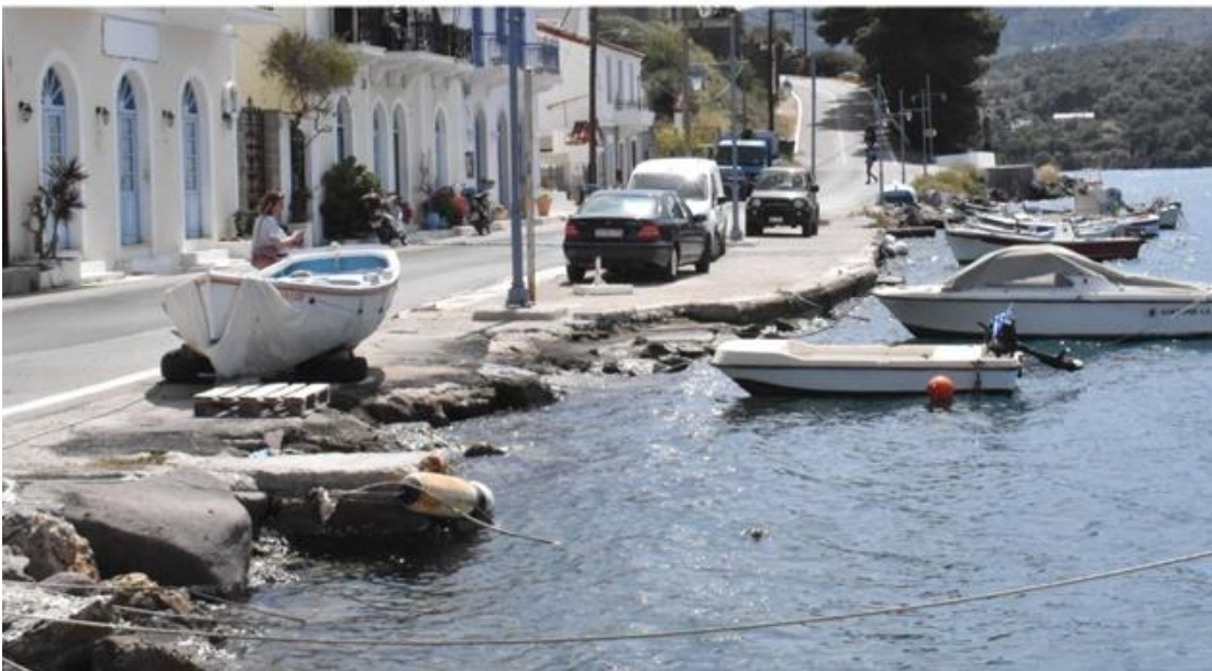
Υφιστάμενη κατάσταση Κρηπιδώματος στην περιοχή επέμβασης
