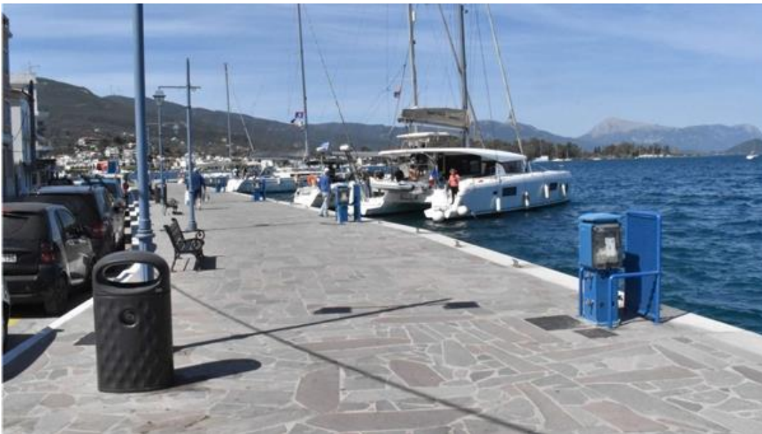
Εικόνα του κρηπιδώματος πριν την περιοχή επέμβασης με αποκατάσταση των αρχικών λίθινων πλακών και σταθμό εξυπηρέτησης Σκαφών
